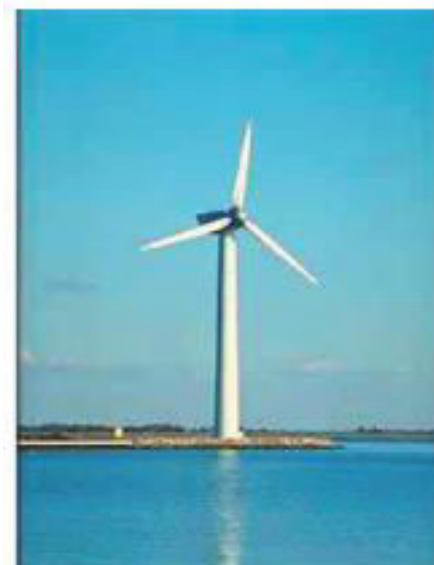
Figura 2. 2 Aerogenerador de eje horizontal. Fuente: Nieves (2011)
