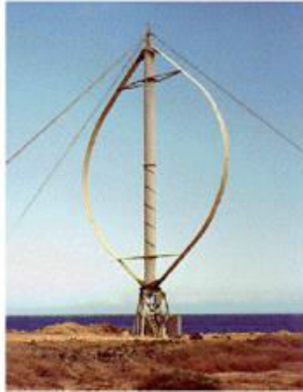
Figura 2. 1 Aerogenerador de eje vertical. Fuente: Nieves (2011)
