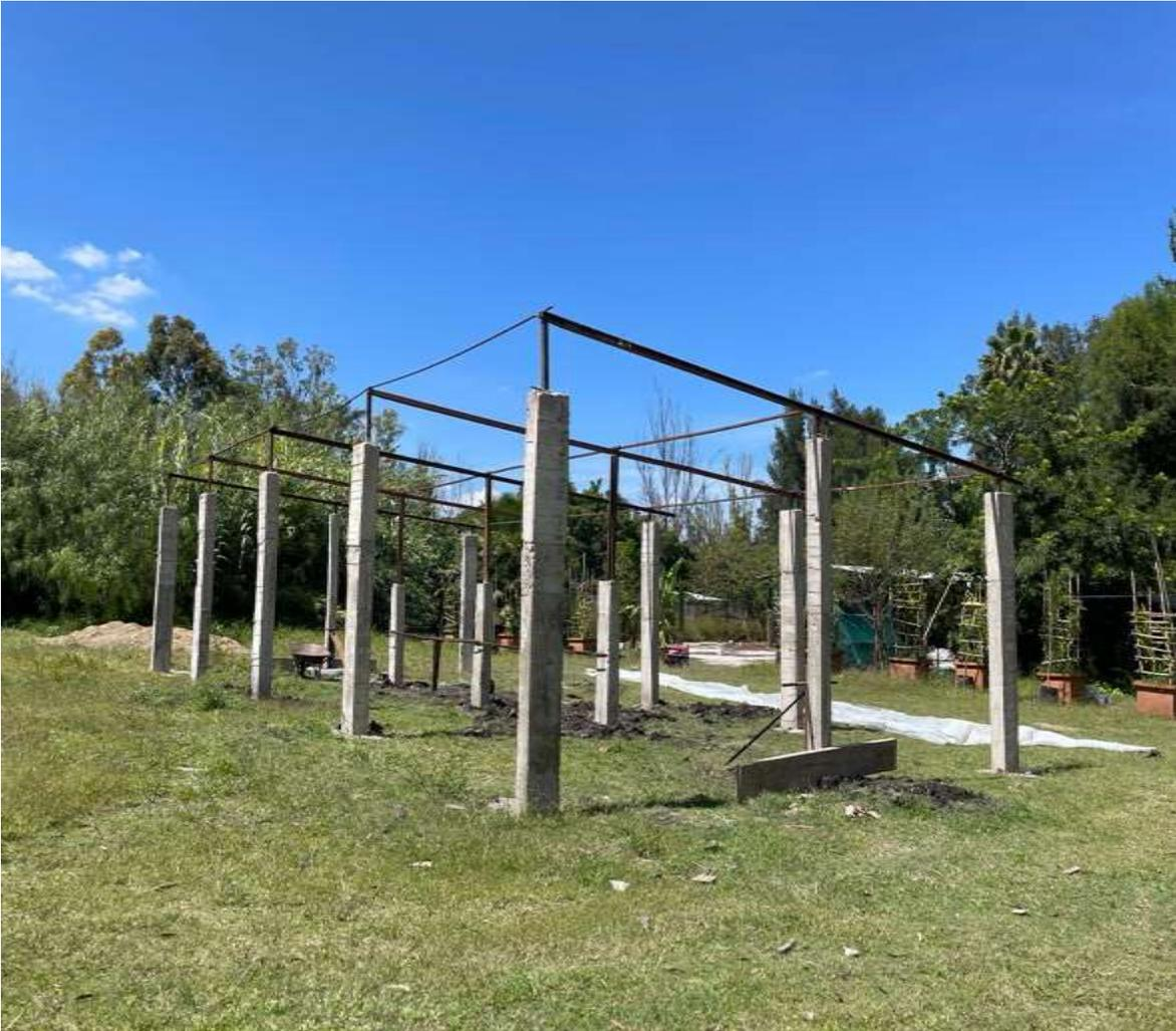
**ILUSTRACIÓN 21 SE HACE COLOCACIÓN ALAMBRE EN CADA UNO DE LOS CUADRADOS DE LA ESTRUCTURA SUPERIOR ESTOS EN FORMA DE X Y OTRO EN MEDIO CRUZANDO Y SOSTENIENDO LA X PARA UN MEJOR SOSTÉN DE LA MALLA SOMBRA QUE CUBRIRÁ TODO EL INVERNADERO.**
