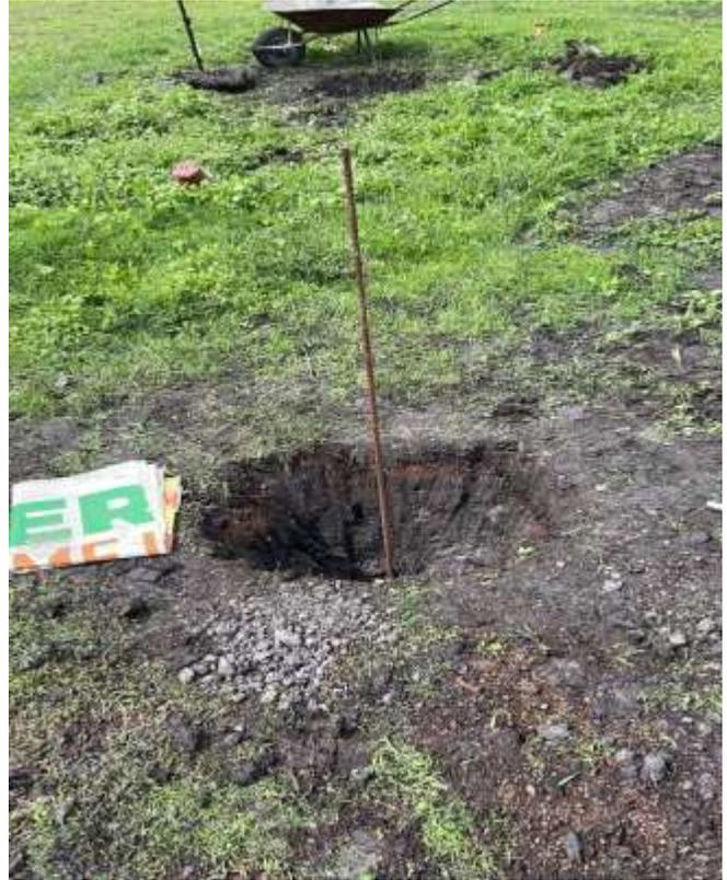
**ILUSTRACIÓN 10 SE MUESTRA LA EXCAVACIÓN PARA LA CIMENTACIÓN DE NUESTRO INVERNADERO CON UNA MEDIDA DE CADA ZAPATA DE 1M X 1M X 1M**
