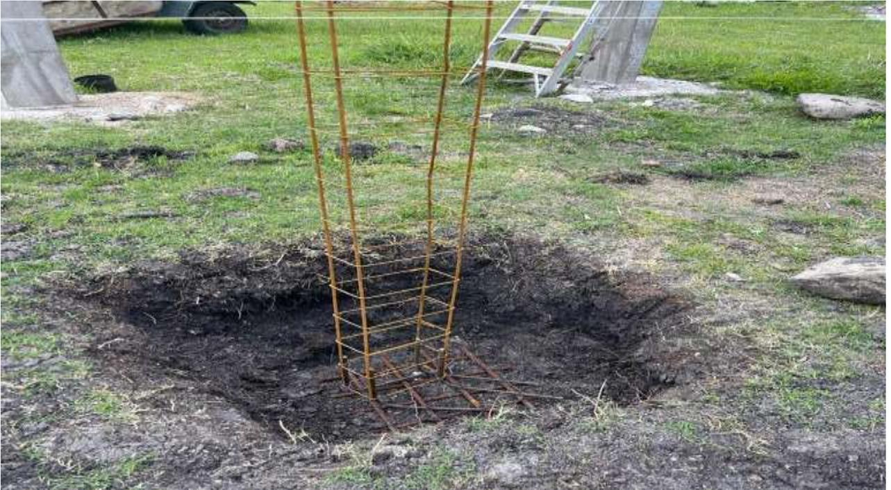
**ILUSTRACIÓN 11 SE MUESTRA LA FABRICACIÓN DE PLANCHAS PARA EL ARMADO DE NUESTROS CASTILLO LOS CUALES SERÁN LA BASE DE NUESTRO INVERNADERO.**
