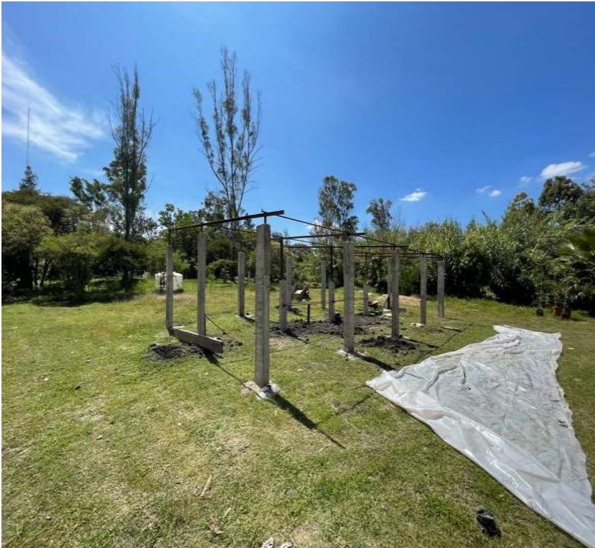
**ILUSTRACIÓN 23 COLOCACIÓN DE PLÁSTICO EN EL INTERIOR DEL INVERNADERO JUSTAMENTE EN EL PISO EL CUAL SE COLOCARA CON EL OBJETIVO DE EVITAR QUE CREZCA HIERBA MALA DENTRO DEL INVERNADERO Y TENER UNA MEJOR CALIDAD DE PLÁNTULAS.**
