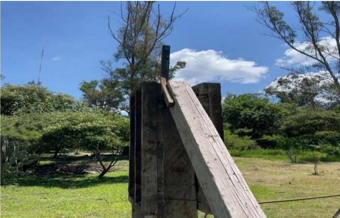
**ILUSTRACIÓN 15 ANTES DE RELLENAR DE CONCRETO POR COMPLETO LOS CASTILLOS SE LE COLOCA UN PTR DE 90 CM EL CUAL VA ENTERRADO EN EL CONCRETO 50CM Y POR FUERA LOS RESTANTES 40CM ESTOS TENDRÁN LA FUNCIÓN DE SOSTENER LA ESTRUCTURA SUPERIOR DE METAL DEL INVERNADERO.**
