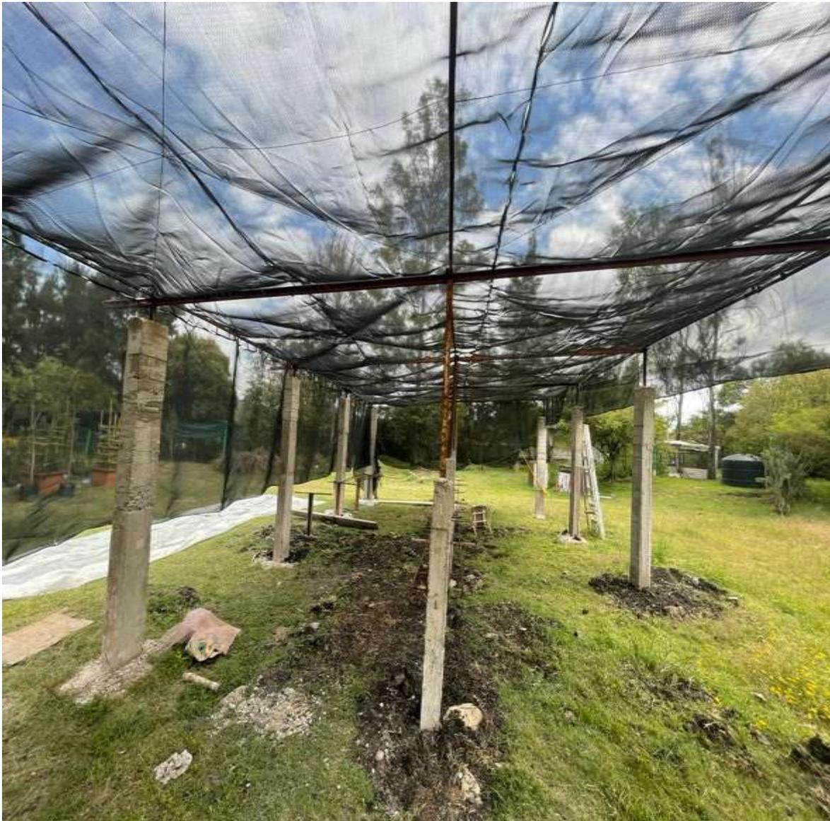
**ILUSTRACIÓN 24 COLOCACIÓN DE MALLA SOMBRA CUBRIENDO TOTALMENTE EL INVERNADERO ESTO PARA MANTENER LA ZONA DE TRABAJO A UNA TEMPERATURA ESTABLE Y ASÍ TENER UNA PRODUCCIÓN MEJOR Y A SU VEZ CONTROLADA, TAMBIÉN EVITAMOS QUE LA SEMILLA TENGA LUZ SOLAR DIRECTA PROVOCANDO QUE LA SEMILLA NO GERMINE.**
