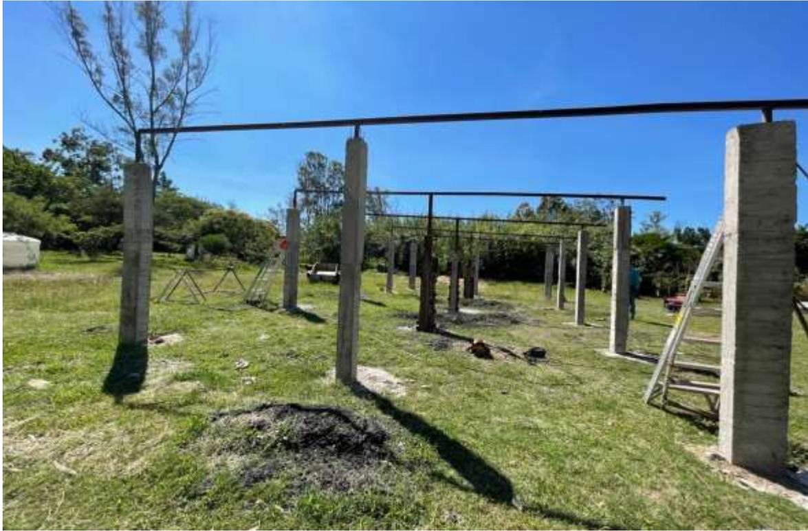
**ILUSTRACIÓN 18** SE PROCEDE AL ENSAMBLADO DE LA ESTRUCTURA SUPERIOR ESTO CON MATERIAL DE ACERO EL CUAL SE CORTARON TRAMOS DE 6,50M LOS CUALES SE SOLDARON A LOS PTR ENTERRADOS EN EL CONCRETO DE LOS CASTILLOS
