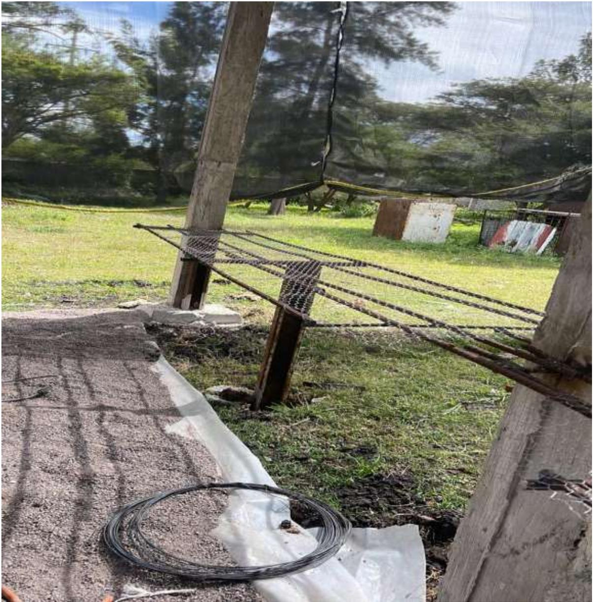
**ILUSTRACIÓN 26 MEJORADO EN LAS MESAS DE TRABAJO SE HIZO LA COLOCACIÓN DE MALLA SOBRE LA VARILLA DE MEDIA PARA DARLE UNA MAYOR ESTABILIDAD A LOS CONTENEDORES Y EVITAR QUE SE TROCEN O SE CAIGAN ENTRE LOS ESPACIOS QUE QUEDAN ENTRE UNA VARILLA Y OTRA.**
