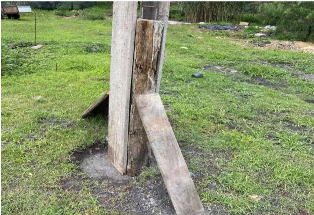
**ILUSTRACIÓN 14** ARMADO DE LOS CASTILLOS PARA SU RELLENE DE CONCRETO Y DEJAR LISTA LA CIMENTACIÓN Y BASE DEL INVERNADERO
