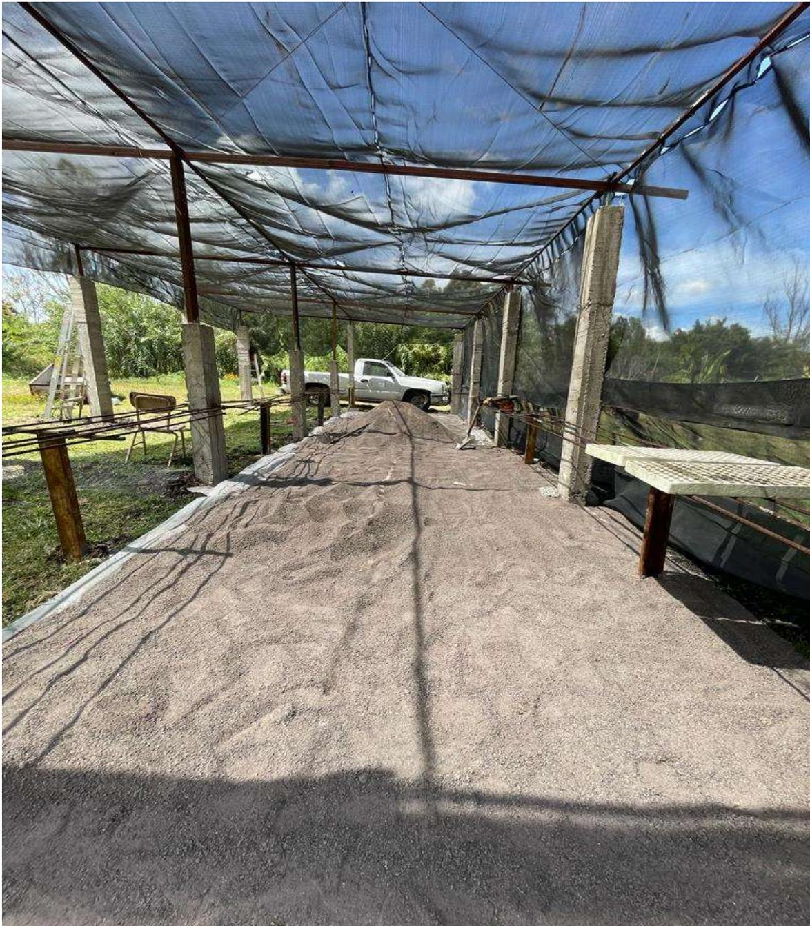
**ILUSTRACIÓN 25 COLOCACIÓN DE POLVO DE GRAVA SOBRE EL PLÁSTICO YA EN EL PISO DEL INVERNADERO ESTO CON EL OBJETIVO DE DARLE UNA MEJOR ESTÉTICA AL INTERIOR DEL INVERNADERO Y DÁNDOLE UN SUELO LIBRE DE HIERBA MALA Y FIRME PARA PODER REALIZAR LAS ACTIVIDADES NECESARIAS DENTRO DEL ÁREA DE TRABAJO ASÍ COMO TAMBIÉN EVITAR ENCHARCAMIENTO EN TIEMPOS DE LLUVIA.**
