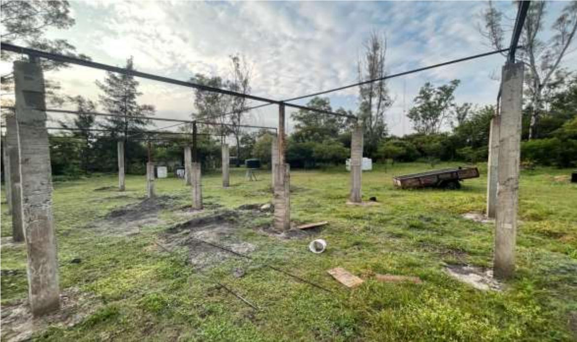
Ilustración 20 armado estructura superior en forma de cuadrado para un mejor maneja y utilidad
