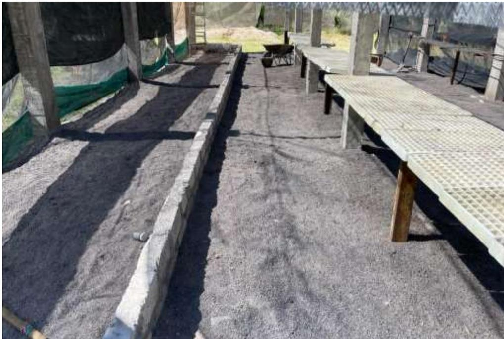
ILUSTRACIÓN 28 ELABORACIÓN DE CHARCA PARA EL ALMACENAMIENTO DE LA PLÁNTULA YA EN SU SEGUNDA FASE Y CUBRIMIENTO TOTAL DEL INVERNADERO CON POLVO DE GRAVA
