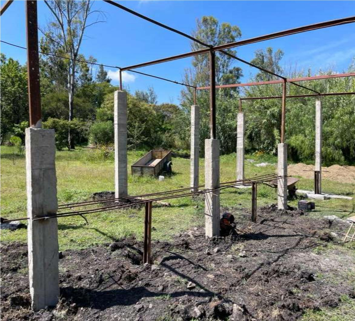
**ILUSTRACIÓN 22** SE REALIZAN LAS MESAS DE TRABAJO DE ACERO ESPECÍFICAMENTE DE VARILLA DE MEDIA PULGADA Y UNOS TRAMOS DE MONTEN LOS CALES VAN ENTERRADOS Y LLENADOS DE CONCRETO PARA DARLE UN MEJOR SOPORTE A LAS MESAS DE TRABAJO LOS CUALES ESTÁN UBICADOS JUSTAMENTE EN MEDIO.
