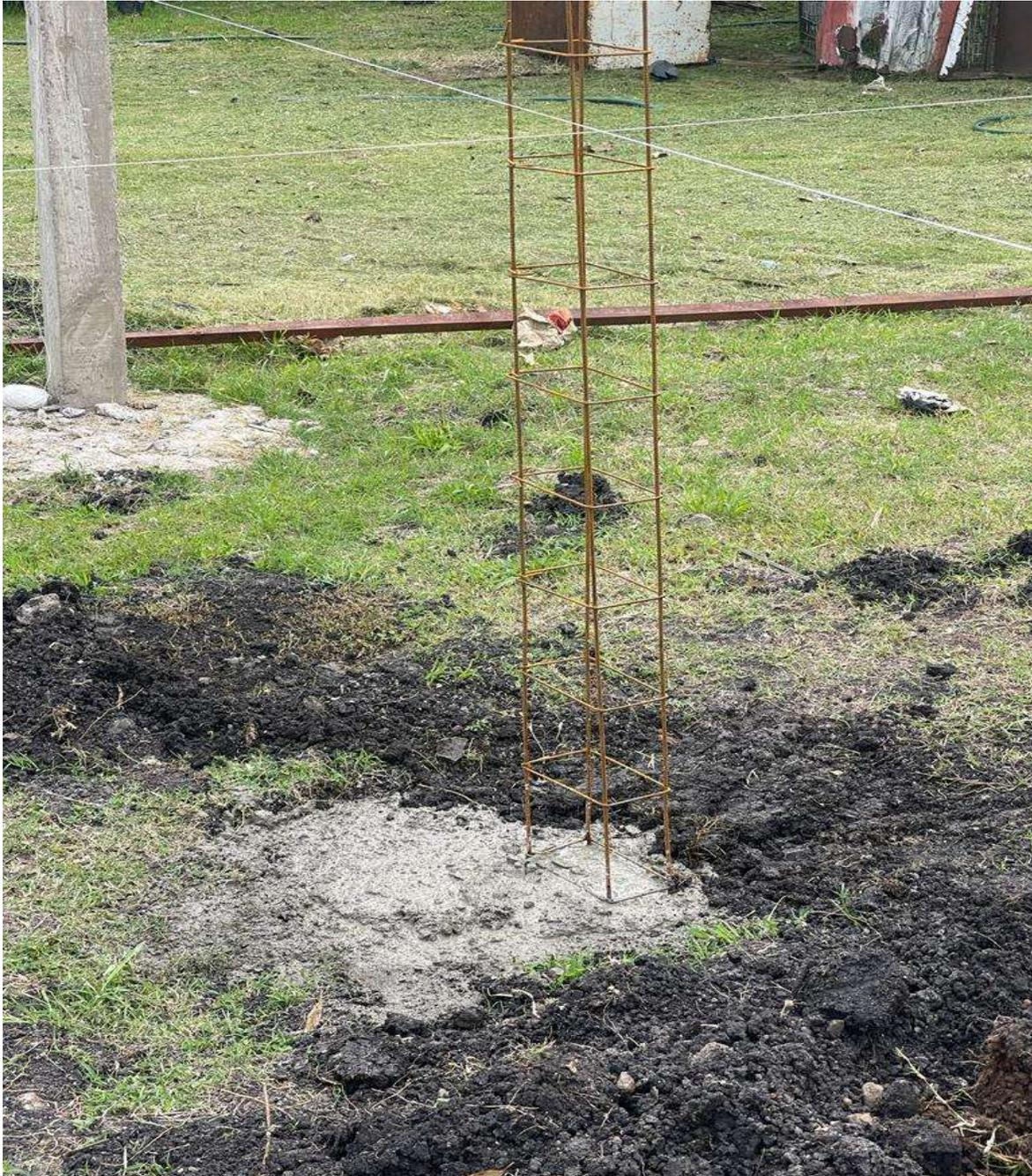
**ILUSTRACIÓN 12 LLENADO DE ZAPATAS CON CONCRETO**
