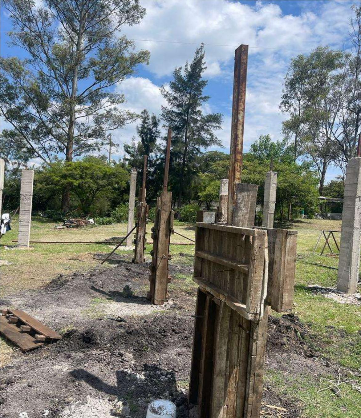
ILUSTRACIÓN 16 EN LOS CASTILLO DE EN MEDIO SE RELLENÓ DE CONCRETO A LA MITAD Y SE PROCEDIÓ A PONERLE UN FIERRO TIPO MONTEN PARA EL SOSTÉN DE LA ESTRUCTURA SUPERIOR ESTO CON EL FIN DE PODER ATORNILLAR LA ESTRUCTURA DONDE IRA LA MANGUERA CONECTADA A LOS MICRO ASPERSORES Y QUE FUNCIONE DE MANERA ÓPTIMA EL SISTEMA DE RIEGO..
