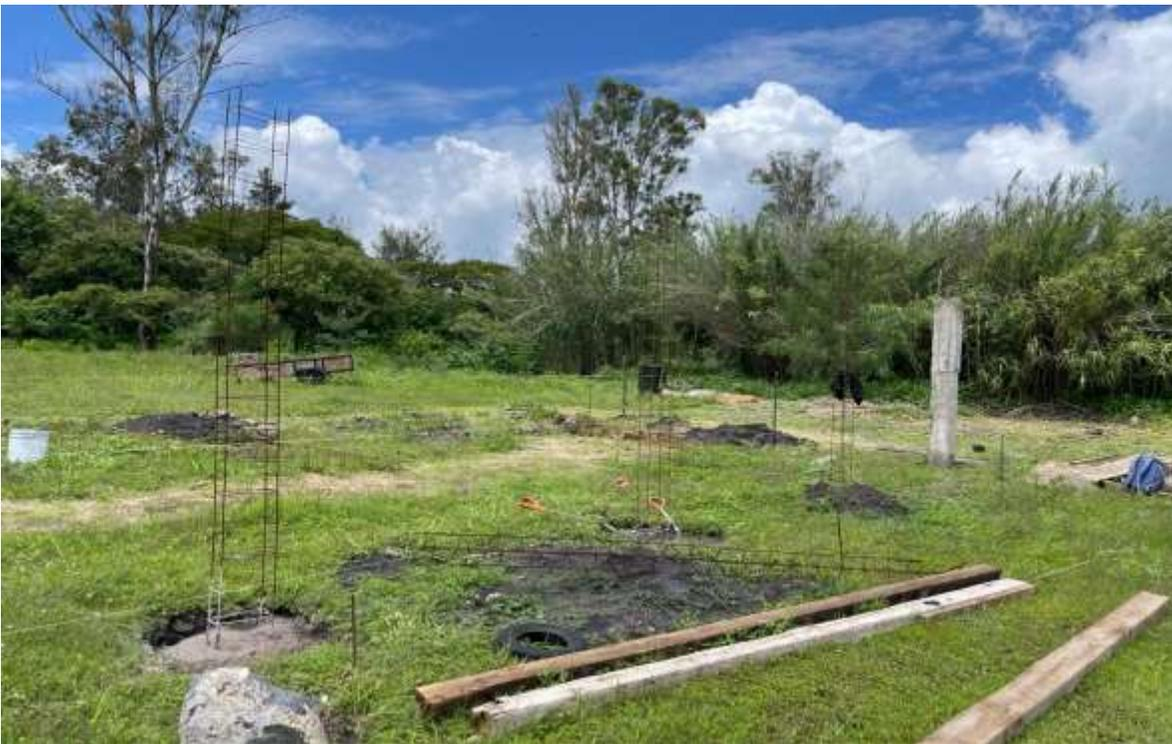
ILUSTRACIÓN 13 NIVELACIÓN DE LOS CASTILLOS
