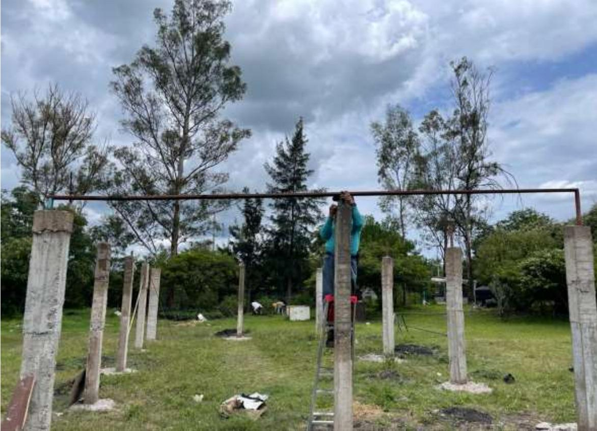
**ILUSTRACIÓN 17 SE COMIENZA EL ARMADO DE LA ESTRUCTURA SUPERIOR, LA SERÁ DE ACERO LOS MISMOS SE ESTÁN COLOCANDO PARA VER SU MEJOR POSICIÓN DE UNA MANERA FIRMA Y POSTERIORMENTE FIJARLAS CON SOLDADURA**
