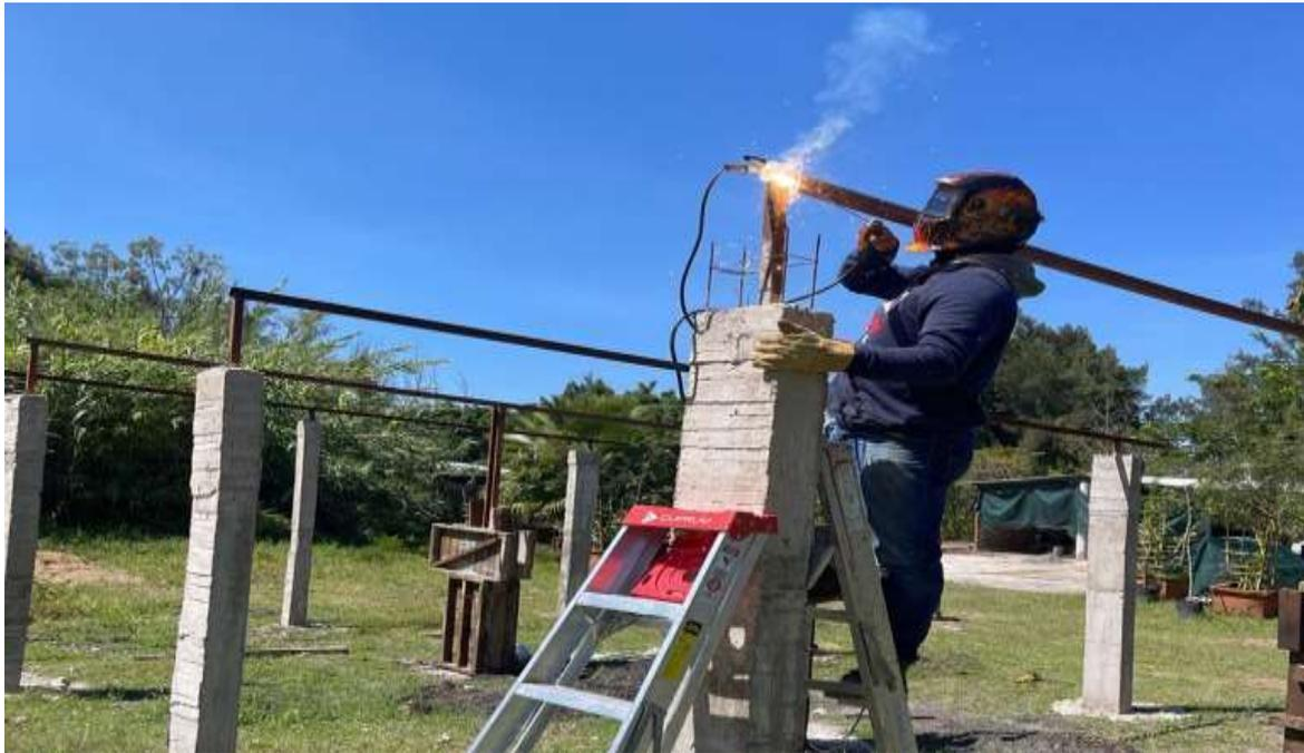
ILUSTRACIÓN 19 ENSAMBLE DE LA ESTRUCTURA SUPERIOR SOLDANDO LOS TRAMOS DE ACERO
