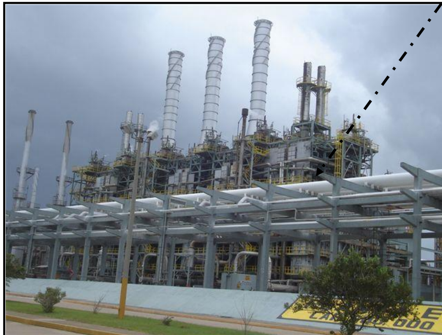
Figura 1.4. Panorámica de la planta de etileno
