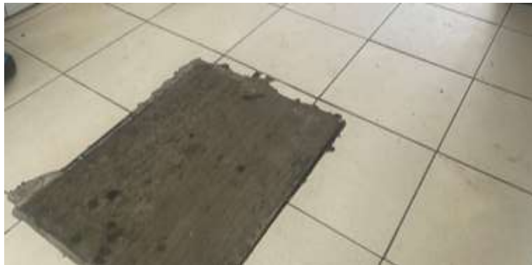
Figura 20. Acabados en pisos, mercado Álvaro Obregón. Fuente: elaboración propia, 2022.
