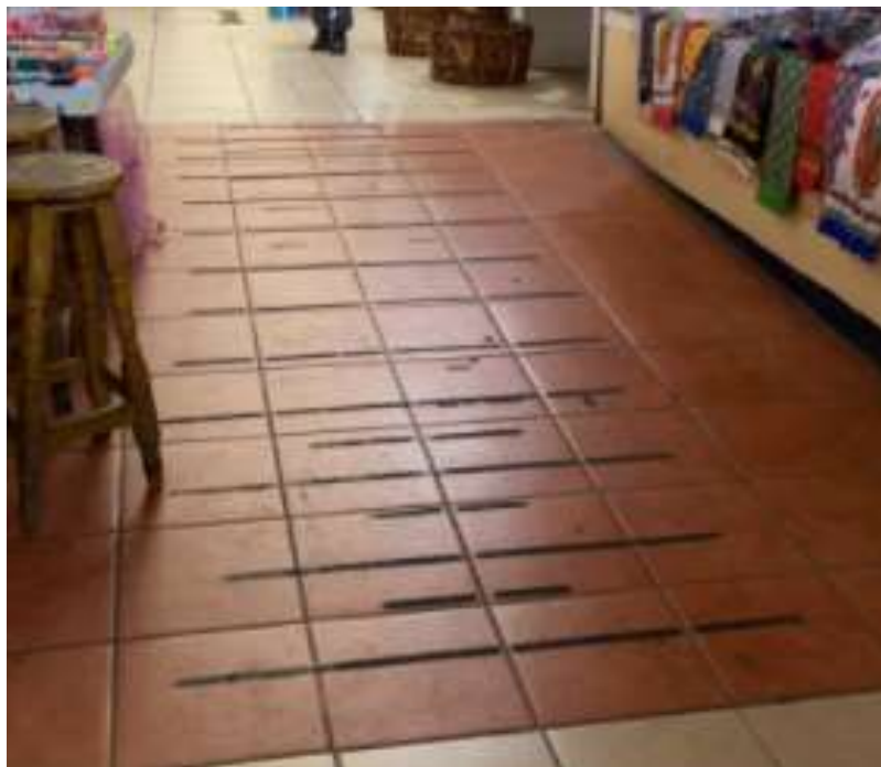
Figura 23. Piso antiderrapante, mercado Álvaro Obregón. Fuente: Ahumada M., 2022.
