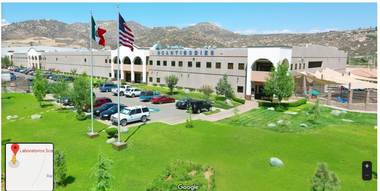
Imagen 2.3. Entrada principal planta A.
