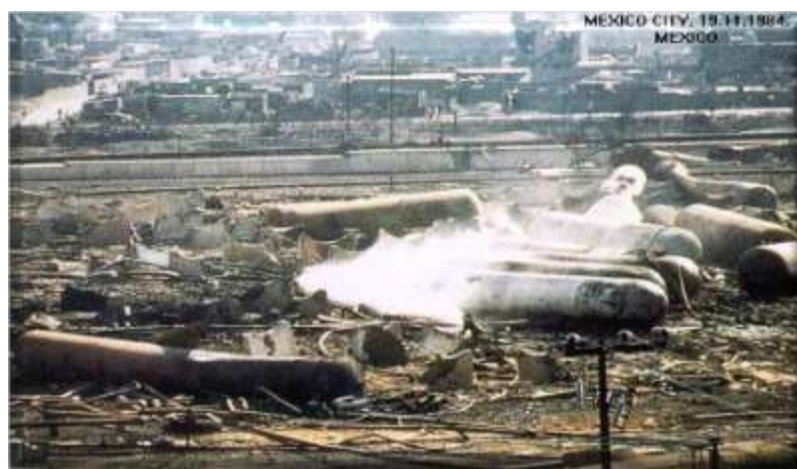
Figura 2.5 Refinería después del accidente de San Juanico, Estado de México (1984).
