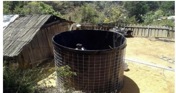
Imagen 5. Cisterna para captación de agua de lluvia en la comunidad del Terrero, Comala. Fuente: https://www.afmedios.com/blog/2016/04/15/instalan-geocisternas-para-captacion-de-aqua-pluvial-en-el-terrero/
