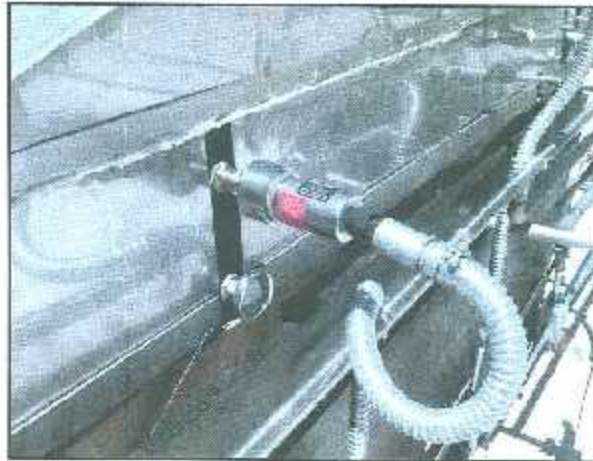
Figura 3.33. Montaje de sensor de presión en estructura de charola.
