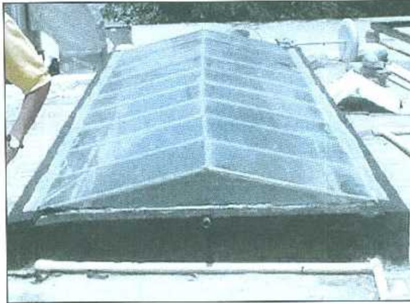
Figura 1.1. Destilador solar instalado en el Tecnológico de la Laguna, año 2002.
