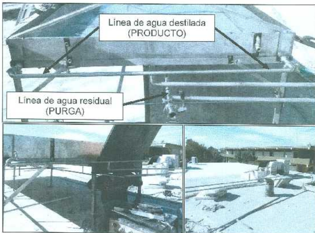
Figura 3.18. Instalación de tubería de agua destilada y tubería de purga.
