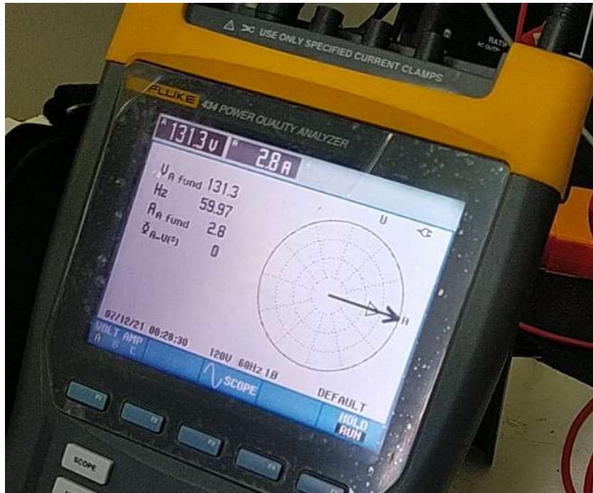
Figura 4.15 Voltaje y Corriente reales medidos por el analizador Fluke
