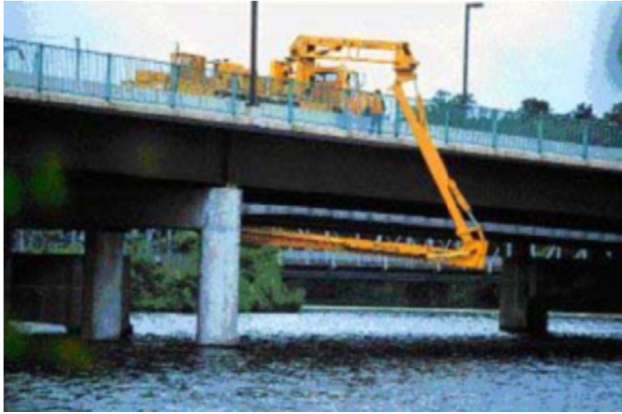
Figura 2.3: Maquinaria pesada usada para la detección de fisuras en puentes.
