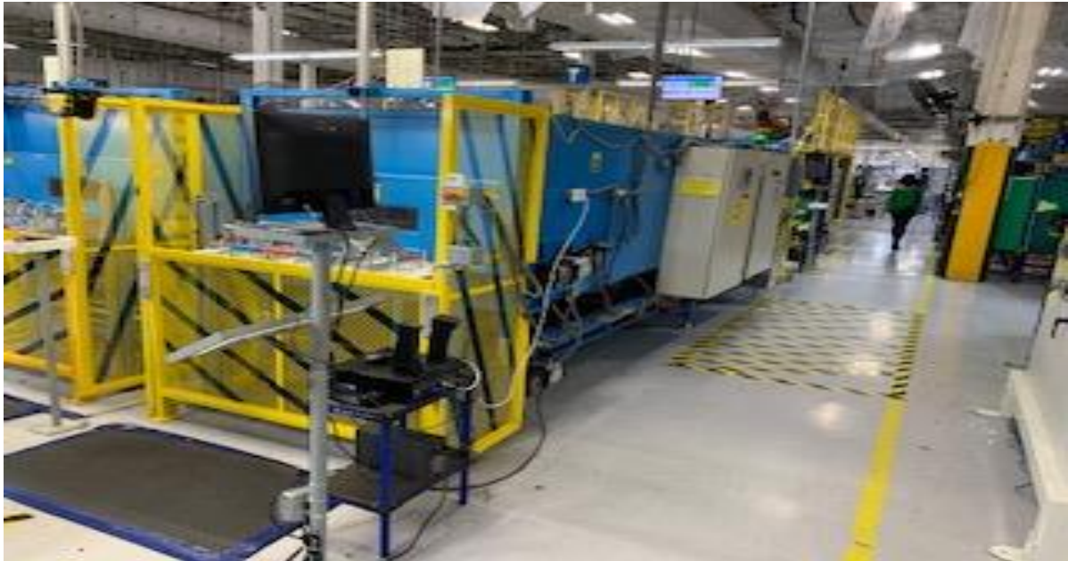
Figura 21– Instalación de horno.
